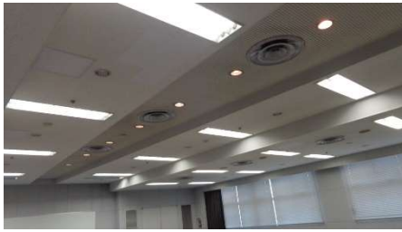
天井材 新旧継ぎ接ぎ
