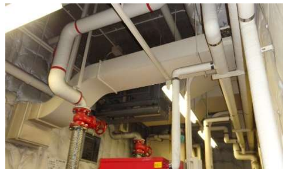
配管支持状況
