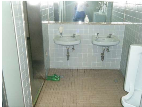
1階男子便所 段差あり
