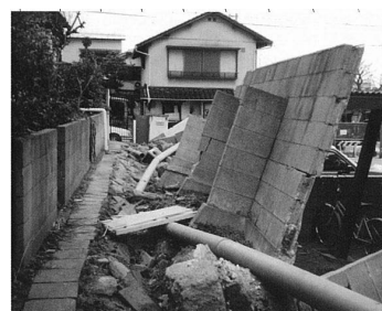
地震によるブロック塀の倒壊
