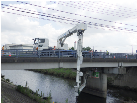
写真-3.1 専門業者による点検状況①
