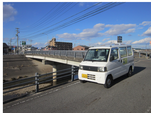
写真-3.4 道路パトロール状況②
