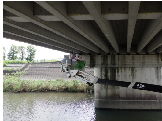
写真-3.2 専門業者による点検状況②
