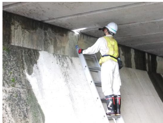
写真-3.2 専門業者による点検状況②
