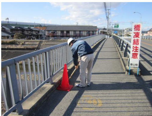
写真-3.3 道路パトロール状況①
