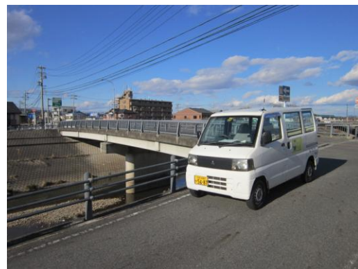
写真-3.4 道路パトロール状況②
