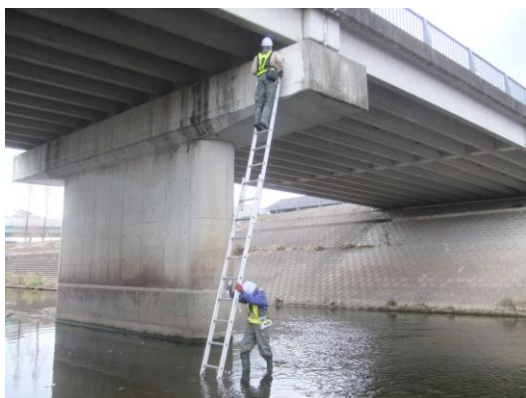
写真-3.1 専門業者による点検状況①
