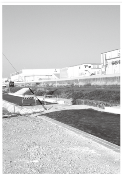
▲整備中の大山川堤防道路
