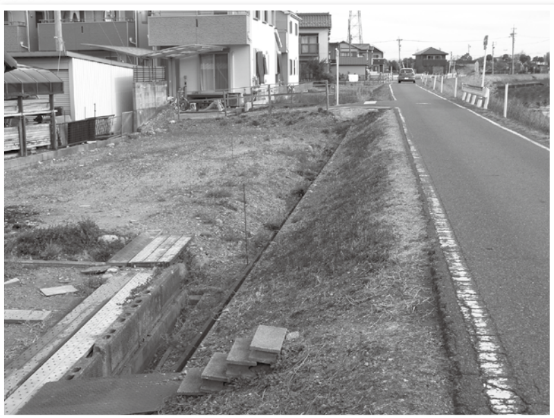
▲工事が始まった遊歩道
