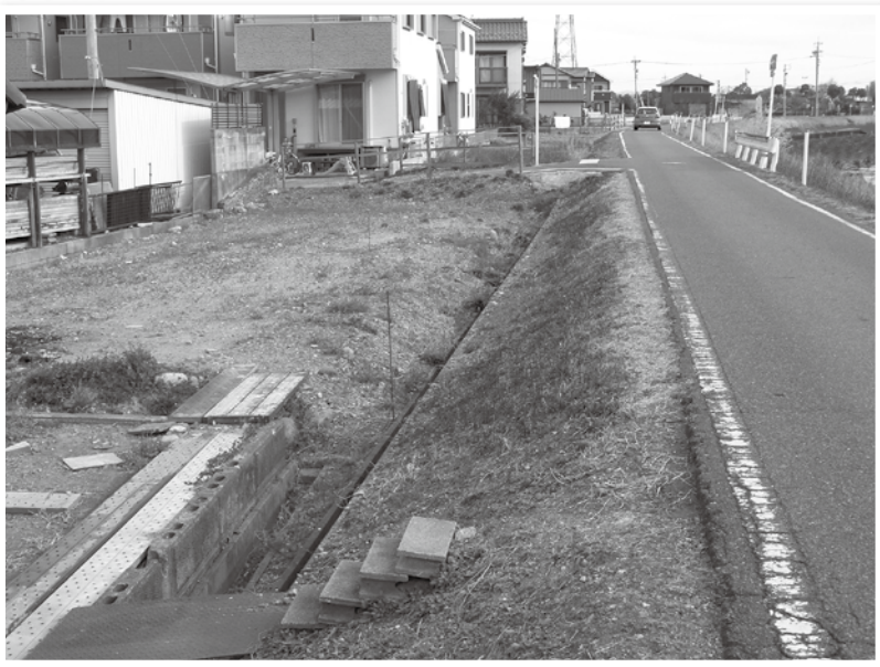
▲工事が始まった遊歩道
