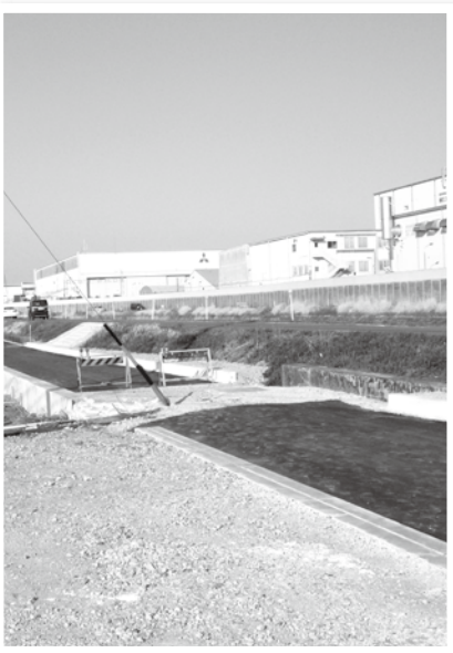
▲整備中の大山川堤防道路
