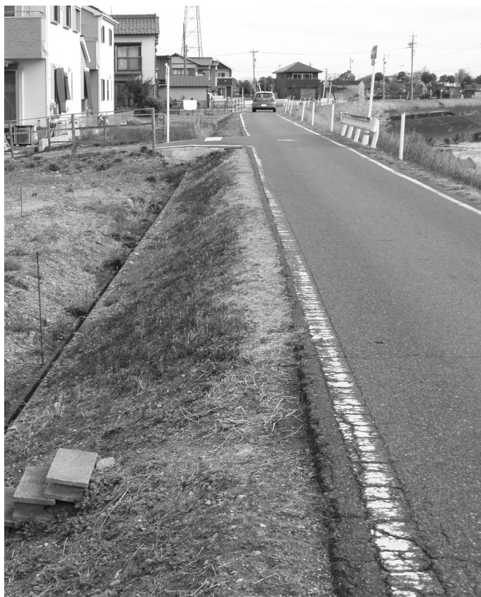
▲整備予定の大山川堤防道路
