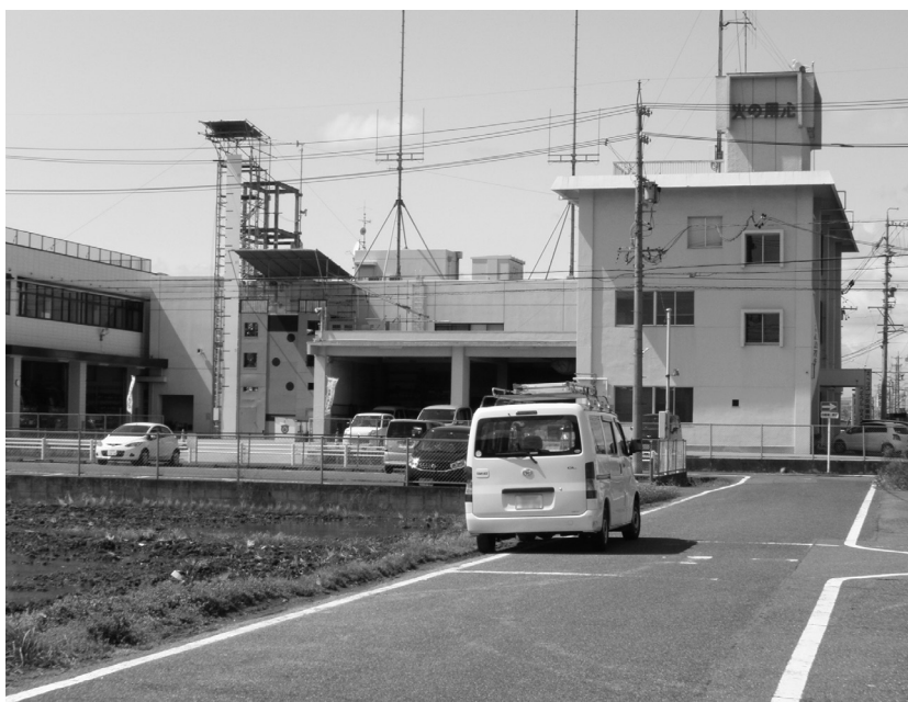
▲西春日井広域事務組合東消防署(北名古屋市)
