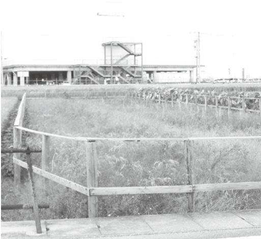
▲町道9号線予定地
