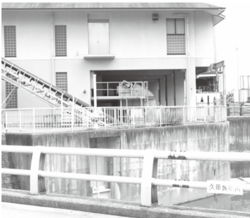
▲久田良木川排水機場
