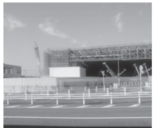
工場完成間近
