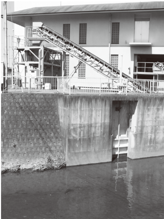
久田良木川排水機場
