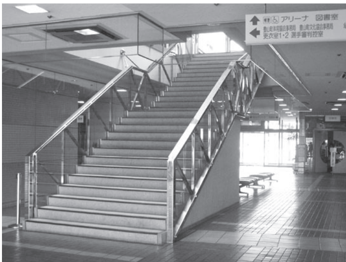
中央にも手すりの設置が望まれる階段
