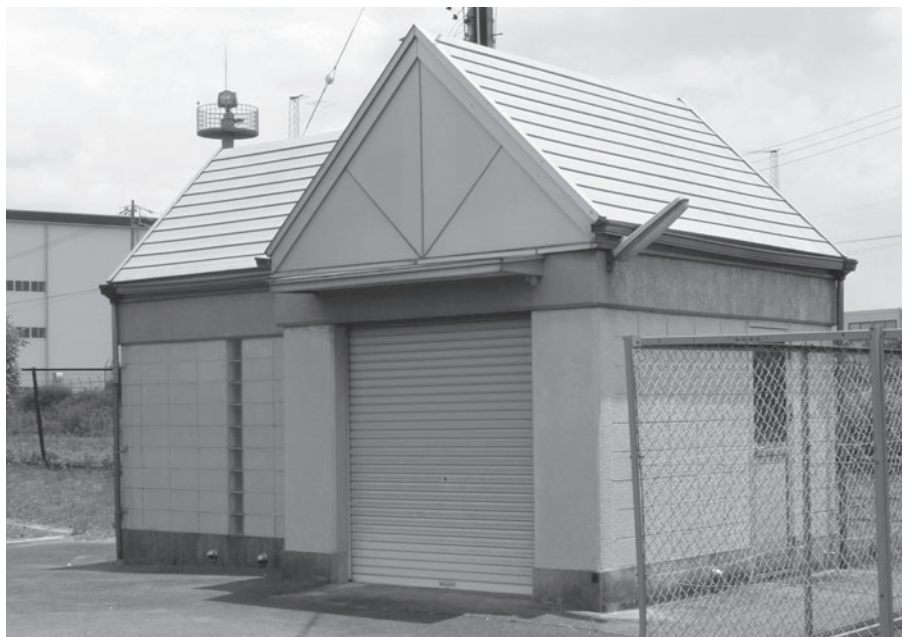
神明にある災害備蓄倉庫
