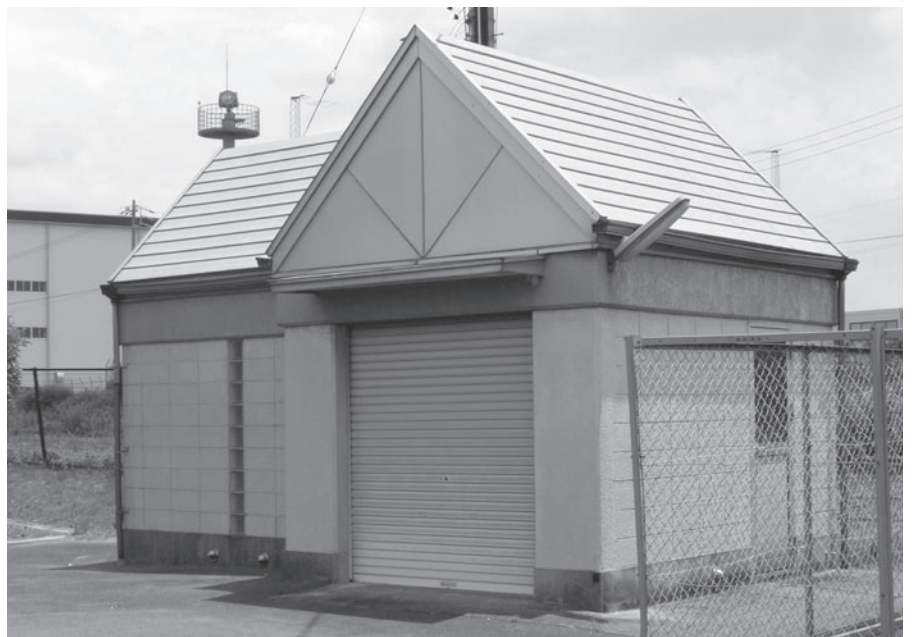
神明にある災害備蓄倉庫
