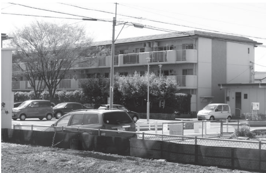
新耐震基準を満たしている町営住宅
