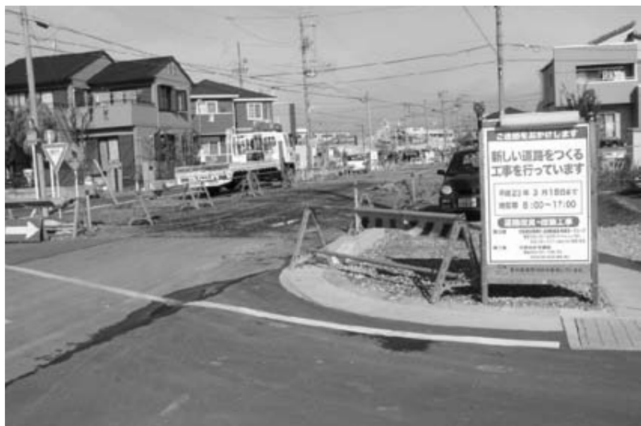
4月からの供用開始を待つ県道
