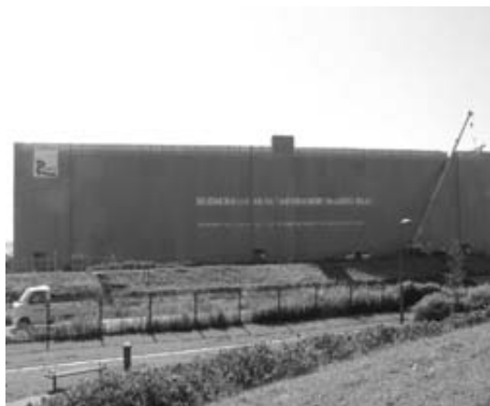
建設が進むJAXAの試験研究施設
