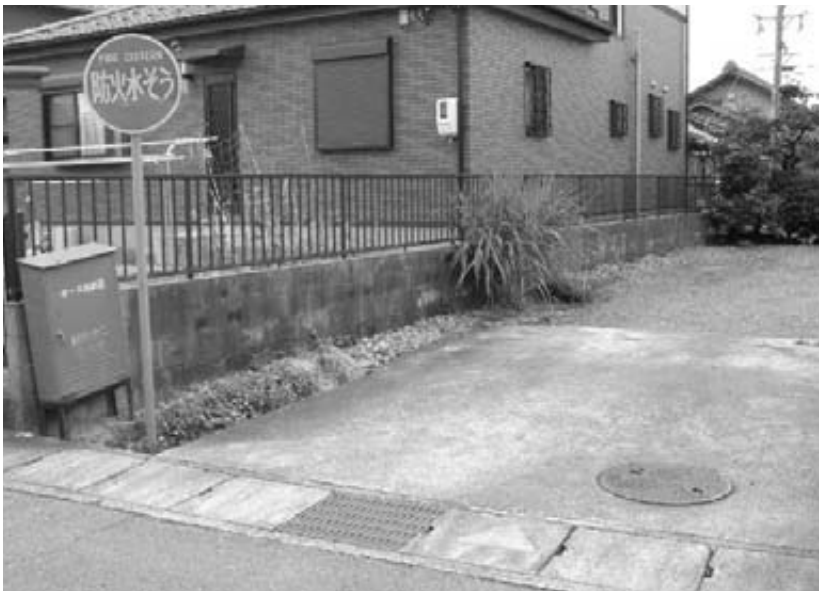
地下に設置された防火水槽
