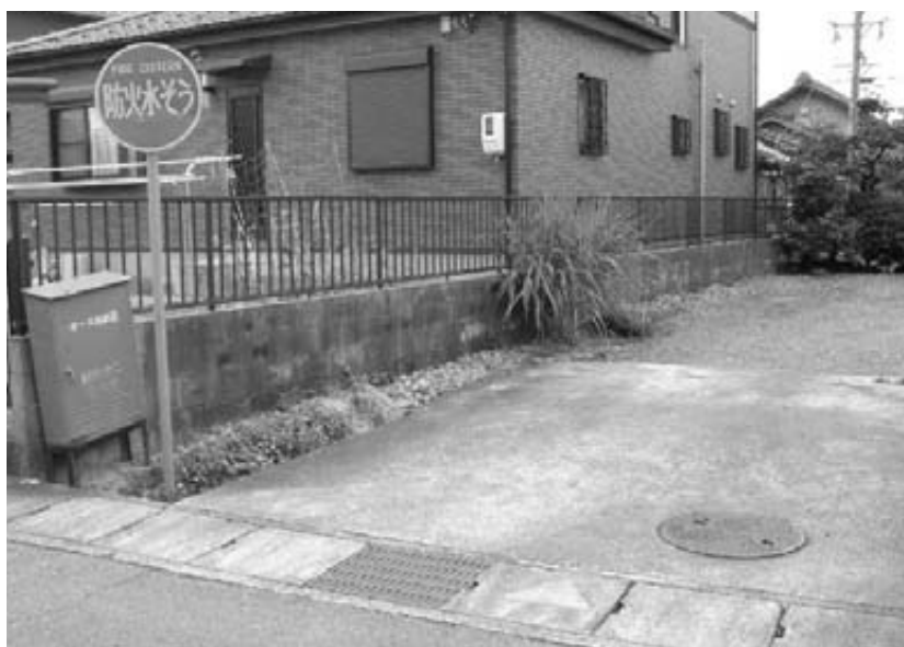
地下に設置された防火水槽
