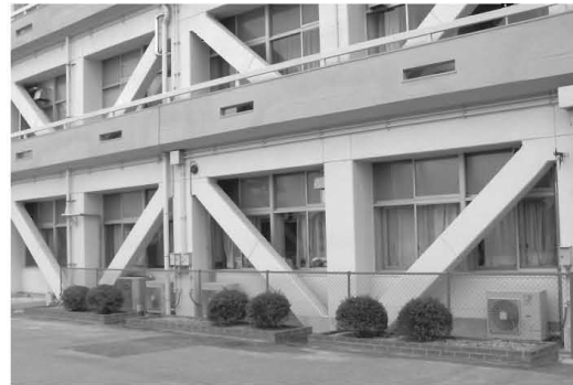
新栄小学校耐震工事
