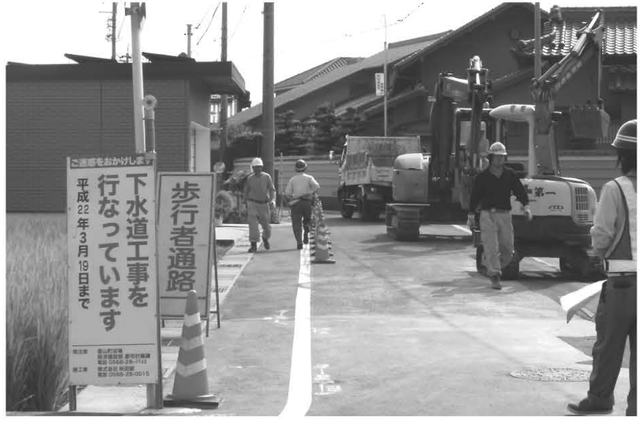
着々と進む下水道工事
