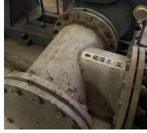
⑤ ロックスライダー機械室 (壁面亀裂、揚水ポンプ・浄化槽ポンプの劣化)
