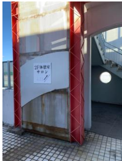
⑪ プール外周 (フェンス亀裂・錆発生、外壁亀裂)
