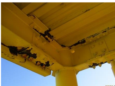
③ ウォータースライダー (外部塗装の劣化、鉄骨部錆発生)
