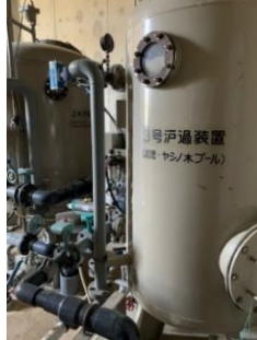
⑥ ろ過器装置 (経年劣化 1号制御盤の更新必要)
