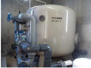
⑥ ろ過器装置 (経年劣化 1号制御盤の更新必要)
