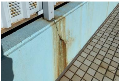
⑪ プール外周 (フェンス亀裂・錆発生、外壁亀裂)
