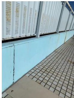
⑪ プール外周 (フェンス亀裂・錆発生、外壁亀裂)
