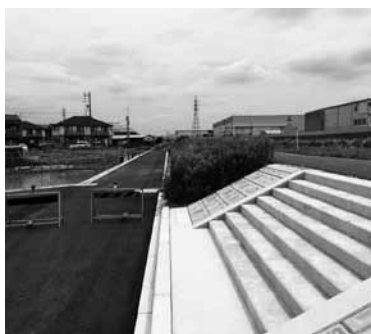
整備中の大山川堤防道路
