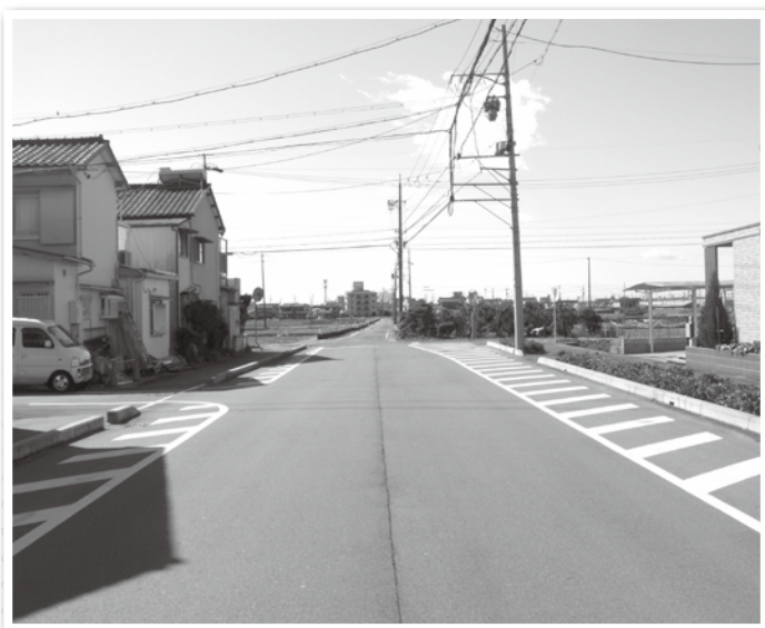
▲整備途中の町道 53 号線
