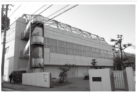
▲プールの可動式屋根の復旧は
