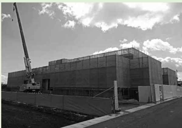
▲建設中の新給食センター
