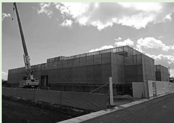
▲建設中の新給食センター
