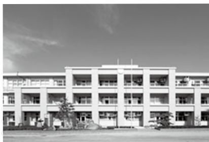
▲まもなく築60年の中学校舎
