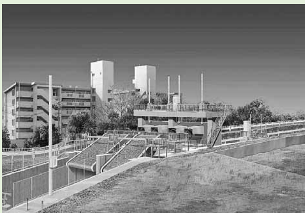
▲久田良木川排水機場増強
