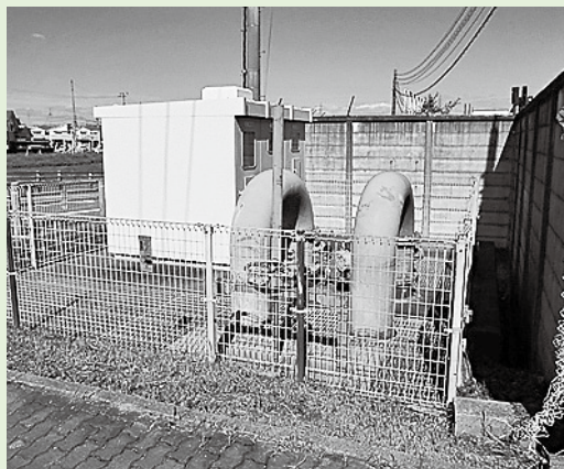
▲ポンプ更新工事
