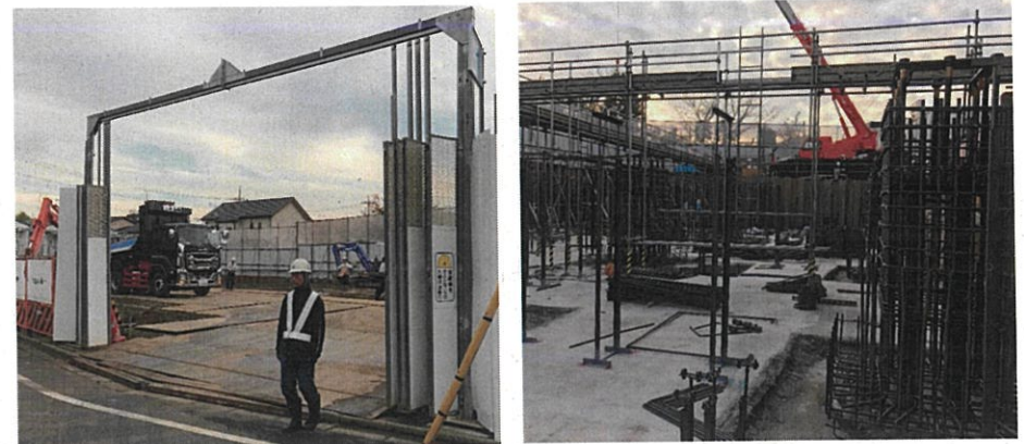
・工事中の安全対策例
