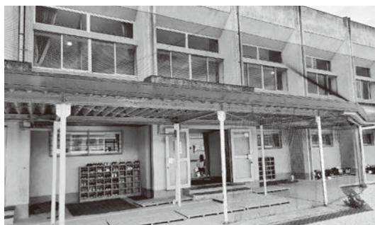
体育館へのエアコン設置は待たなし
