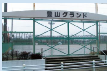
スポーツ施設の改修
