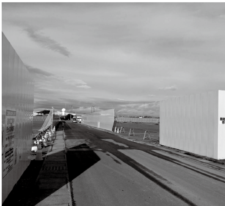
工事中の基幹的広域防災拠点
