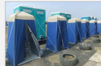
マンホールトイレ
