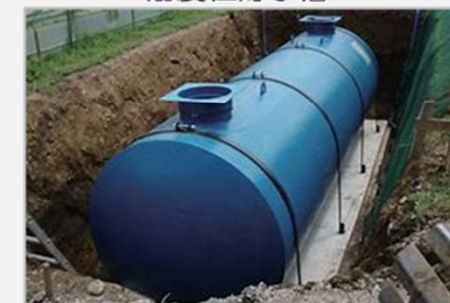
耐震性貯水槽
