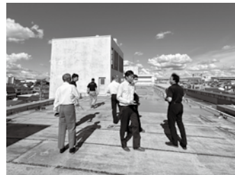
中学校屋上の雨漏り調査
