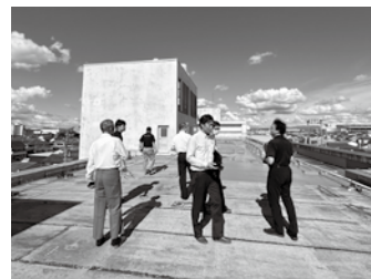
中学校屋上の雨漏り調査
