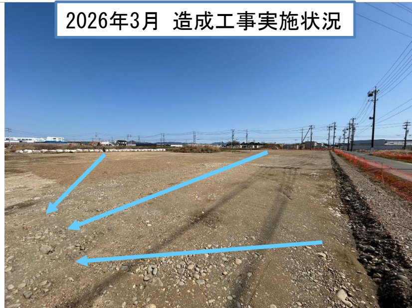
2026年3月 造成工事実施状況
