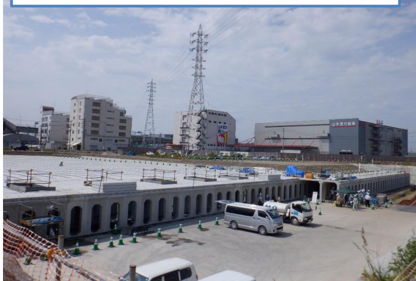
2025年10月 調整池本体完成、埋戻し開始
