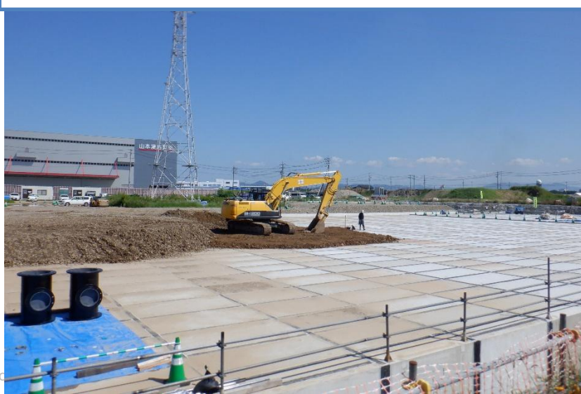
2025年10月 調整池本体完成、埋戻し開始
