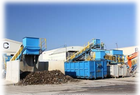
出典：災害廃棄物対策フォトチャンネル 東日本大震災・仮設選別施設（宮城県）
