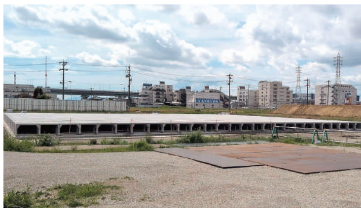
調整池建設中
