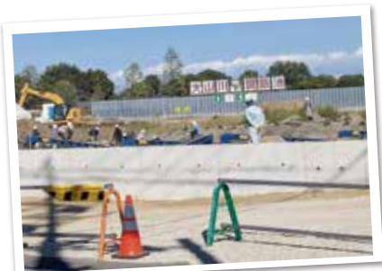
造成中の防災公園
